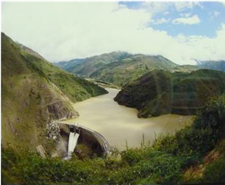
Represa de Santo Domingo, sobre el río del mismo nombre, en el Estado Mérida.
