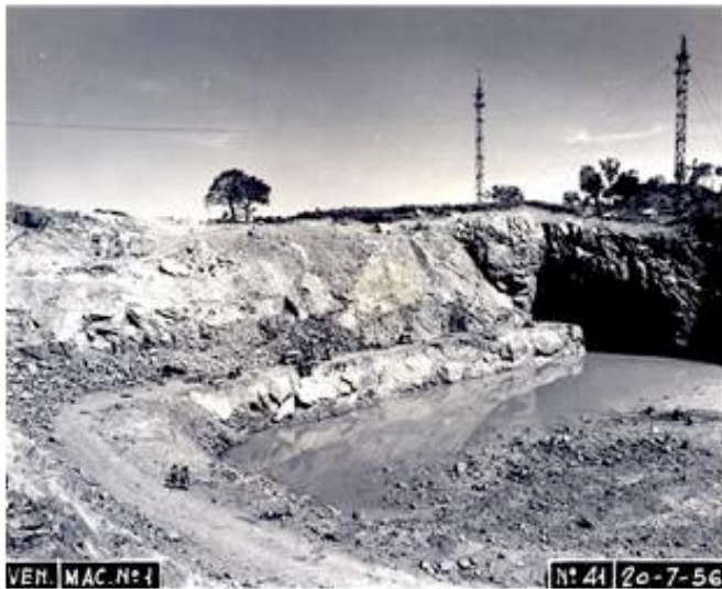
Construcción de la planta Macagua I, sobre el río Caroní (20/7/1956).
