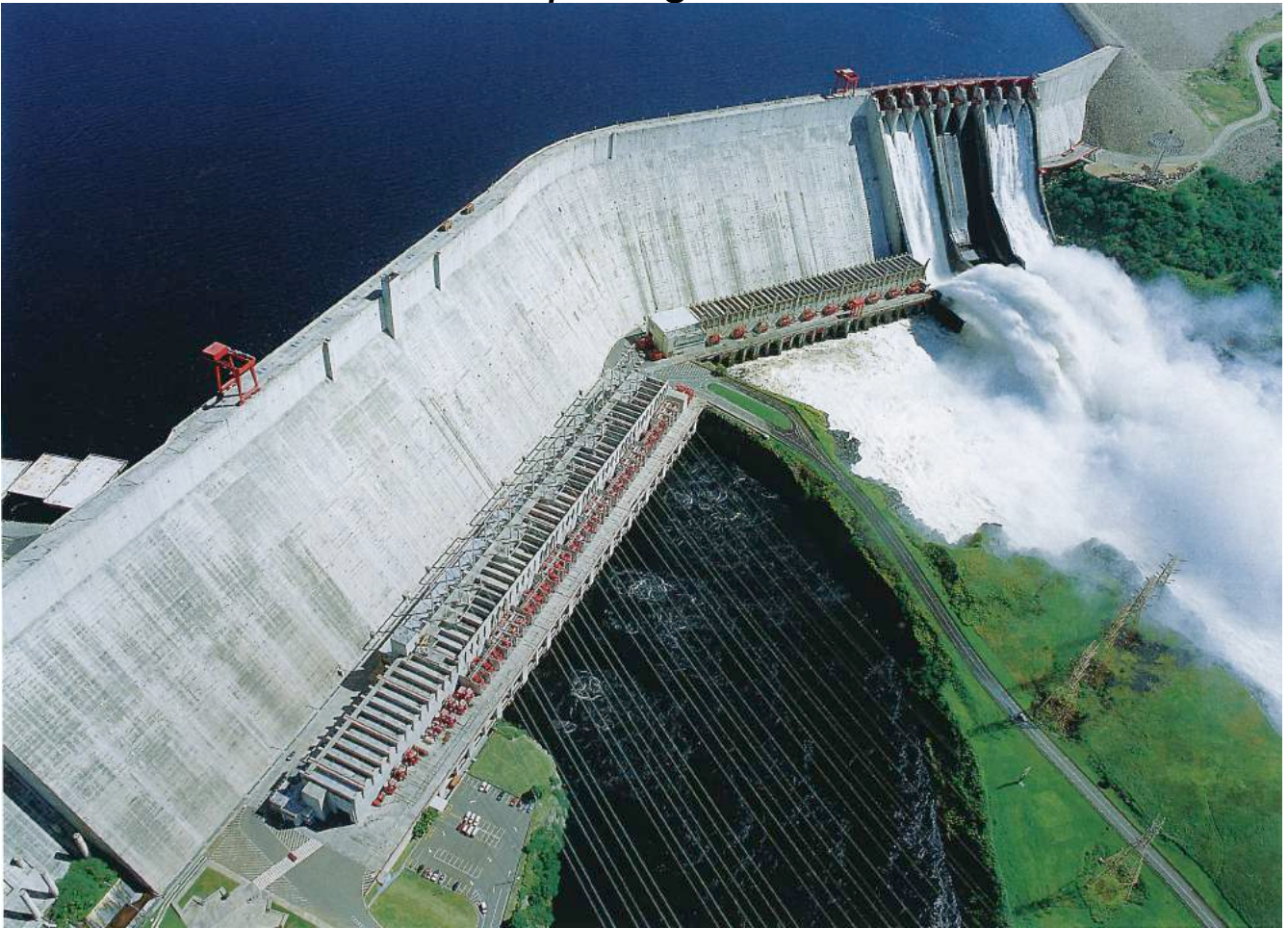
Vista general de la Central Hidroeléctrica Guri 8.875 MW
