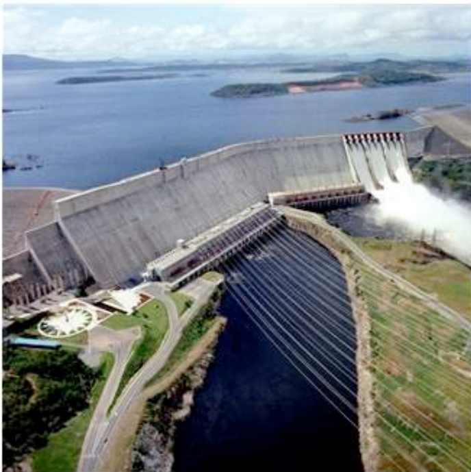
Vista aérea de la presa de Guri (22/1/1987).
