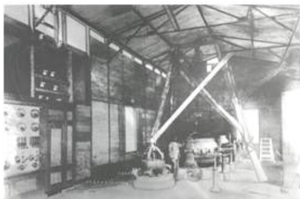
Planta El Encantado - Montaje de los primeros dos generadores, de 210 kW c/u. 1897.
