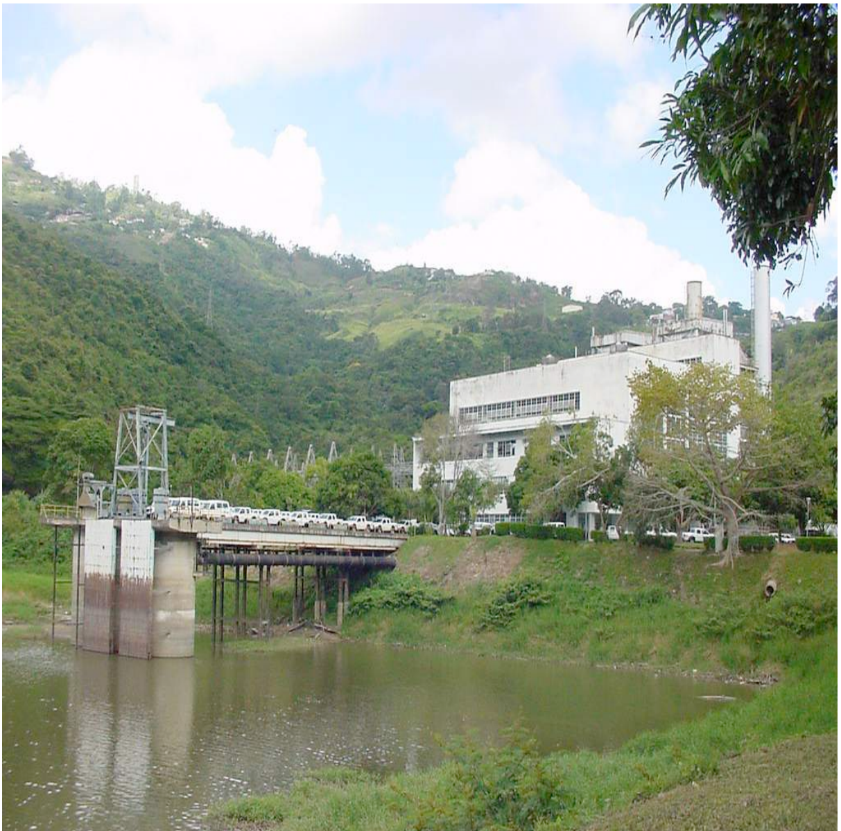
Planta Termoeléctrica de La Mariposa, 1956
