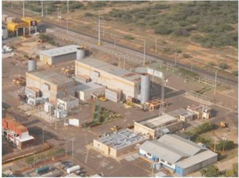
Vista parcial de la Central Rafael Urdaneta.
