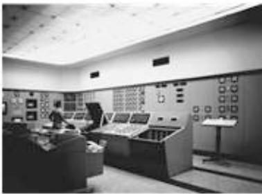
Casa de Máquinas 1.
