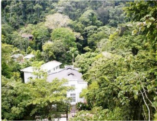
Central hidroeléctrica La Uraca-Choroní.
