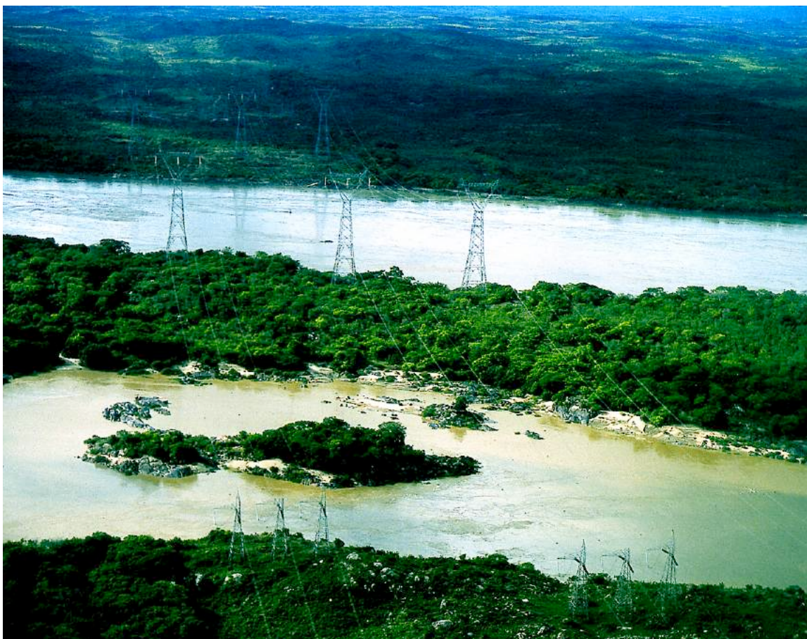
Cruce sobre el río Orinoco en la isla del Infierno del sistema 765 kV.
