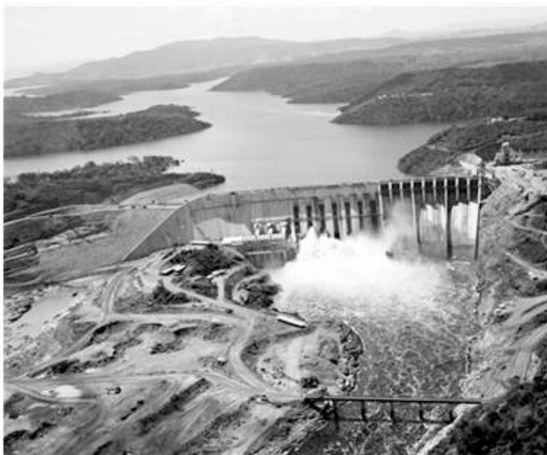
Vista aérea frontal de la presa de Guri hacia finales de 1968, al culminar la primera fase de la primera etapa (31/10/1968).
