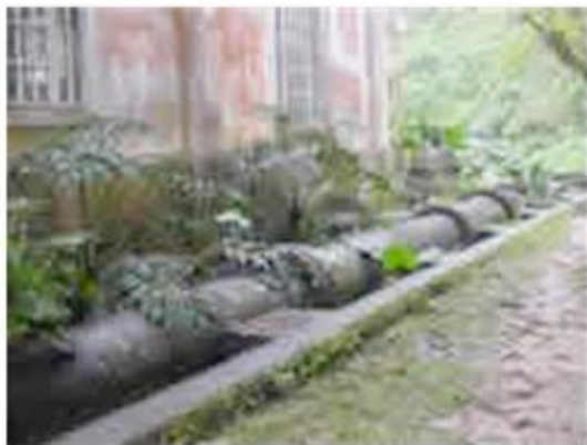
Central hidroeléctrica Choroní.
