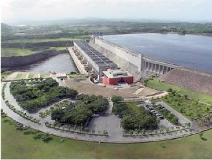
Planta Macagua II, sobre los saltos inferiores del río Caroní.
