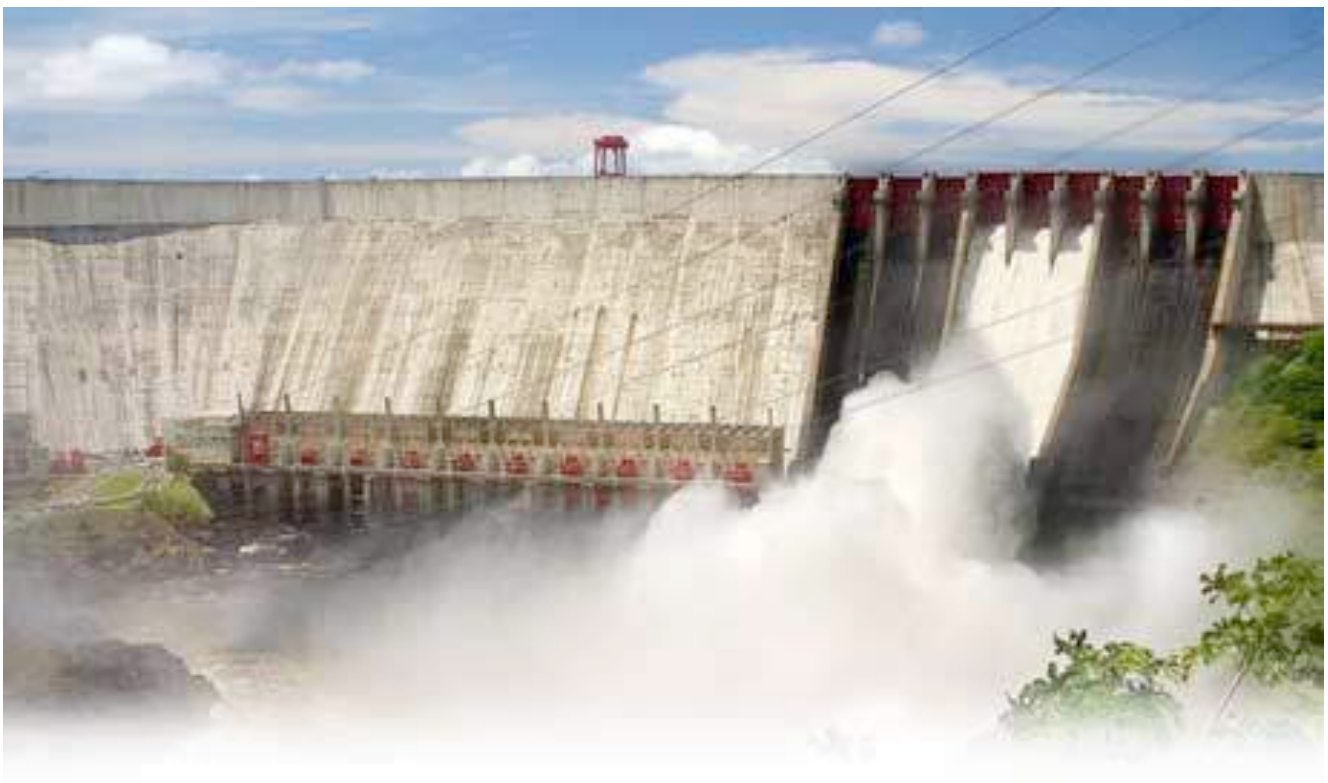
Represa de Guri, primera etapa 1965-1978, 10 turbinas Francis con potencia de 2.575 MW.
