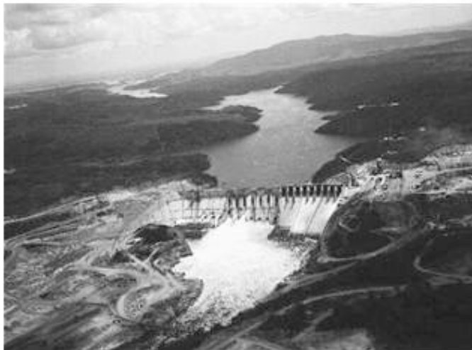
Vista aérea de la presa de Guri (5/10/1968).
