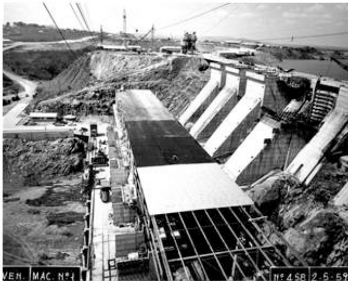
Avance en la construcción de la planta Macagua I, sobre el río Caroní (2/5/1959).
