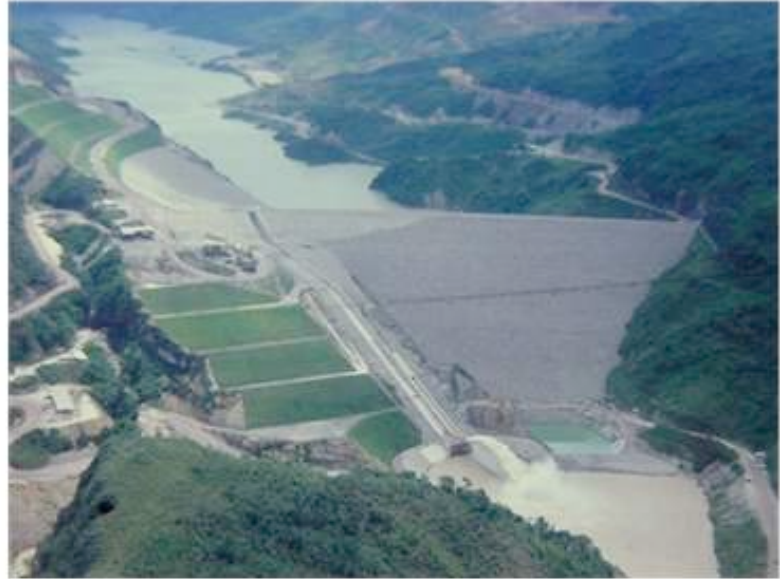
Presa La Honda, sobre el río Uribante, en el Estado Táchira.
