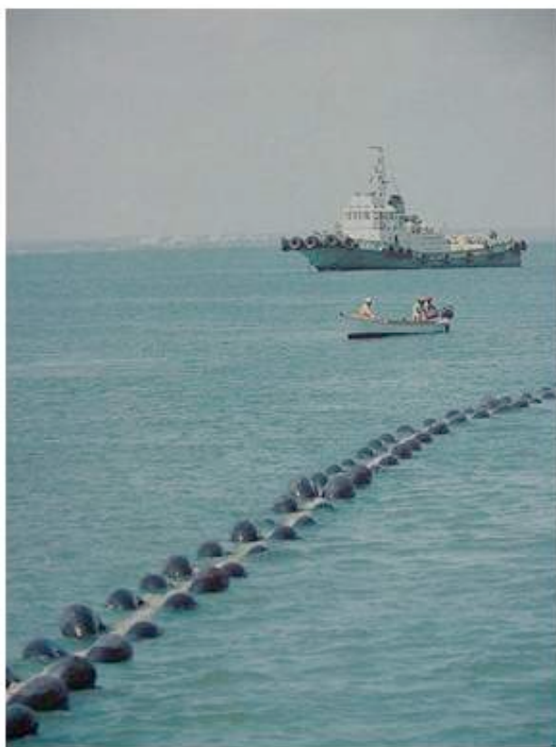
Tendido de cable submarino desde tierra firme hasta la Isla de Margarita.
