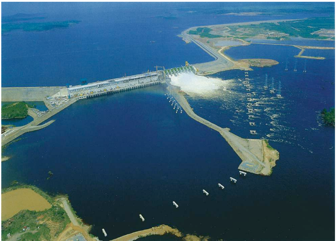
Central hidroeléctrica Caruachi. Capacidad máxima 2.160 MW, 12 unidades de generación.
