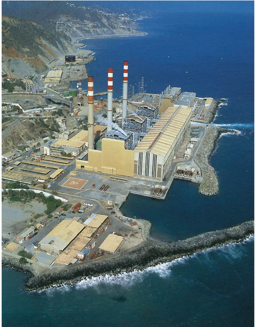
Conjunto Generador Ricardo Zuloaga (Planta Tocoa). Arrecife, Estado Vargas
