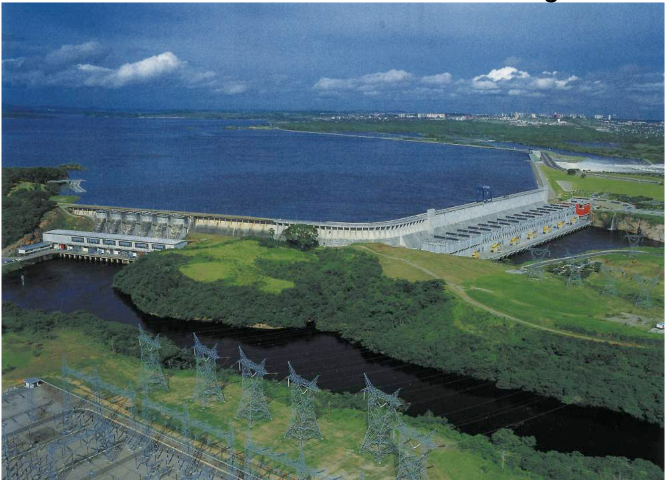
Vista general de la Central Hidroeléctrica Macagua, Casas de Máquinas I, II, III y aliviadero. Capacidad máxima: 3.140 MW, 20 unidades de generación.
